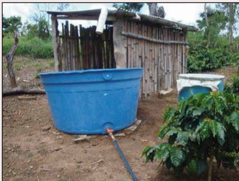
Sistema simplificado de captação de água de chuva que pode ser utilizado por pequenos produtores. (Fonte: Associação Hanns R. Neumann Stiftung do Brasil)
