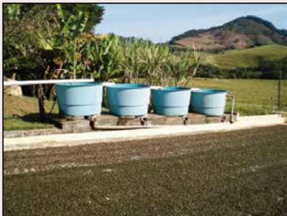
Sistema de reciclagem de água residual do despulpamento do café. (Fonte: Universidade do Café Brasil - Illy)
