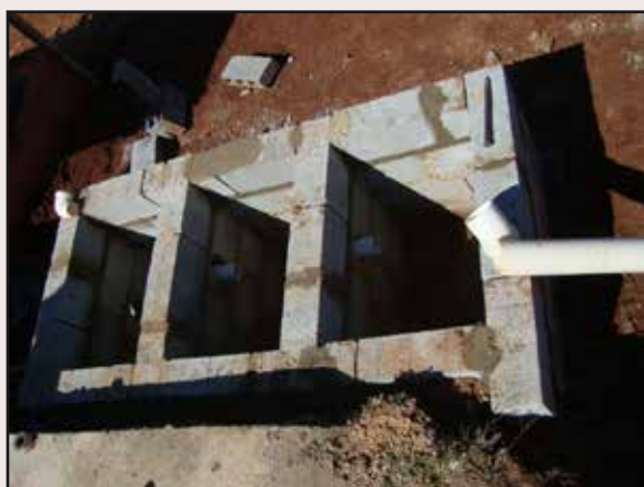
Caixa separadora de água e óleo. Modelo de alvenaria construído na propriedade (à esquerda) e modelo pronto para instalação (à direita). (Fonte: Pedro Ronca)
