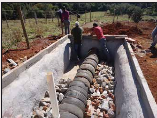
Fossa ecológica ou tanque de evapotranspiração. (Fonte: EMATER MG)
