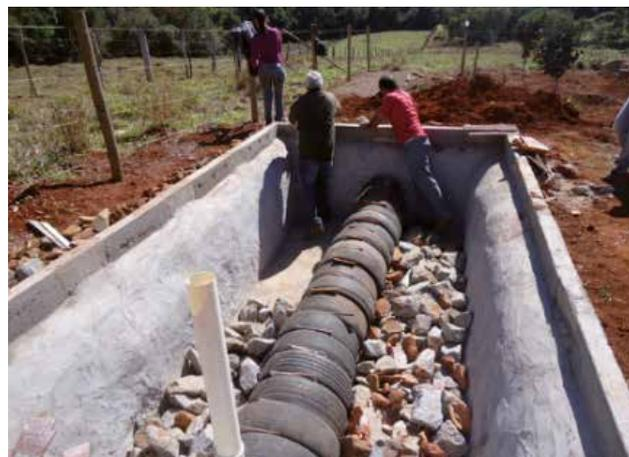
Figura 28. Fossa ecológica ou tanque de evapotranspiração. (Fonte: Emater-MG)
