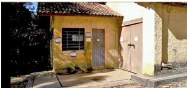
Figura 35. Depósito identificado, trancado e com sistema para contenção de vazamentos. (Fonte: Eduardo Matavelli)
