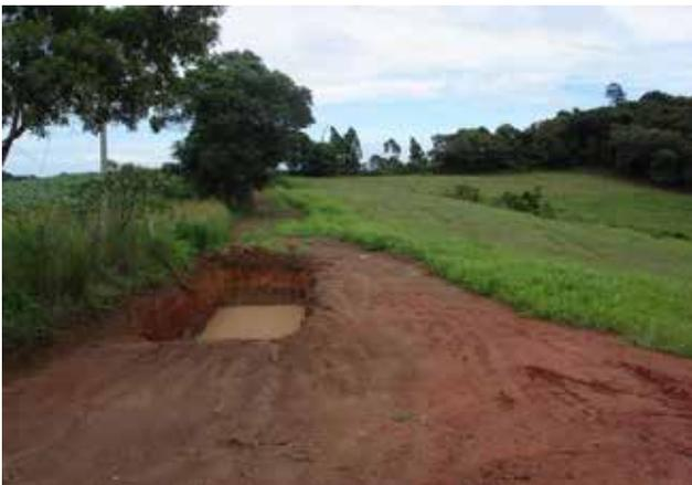
Figura 13: Caixa de contenção de água da chuva, evitando erosão nos caminhos internos da propriedade. (Fonte: Pedro Ronca)
