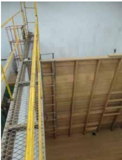
Figura 49: Escada interna de tulha de café sem proteção guarda corpo. Risco de acidente. (Fonte: Eduardo Matavelli)
