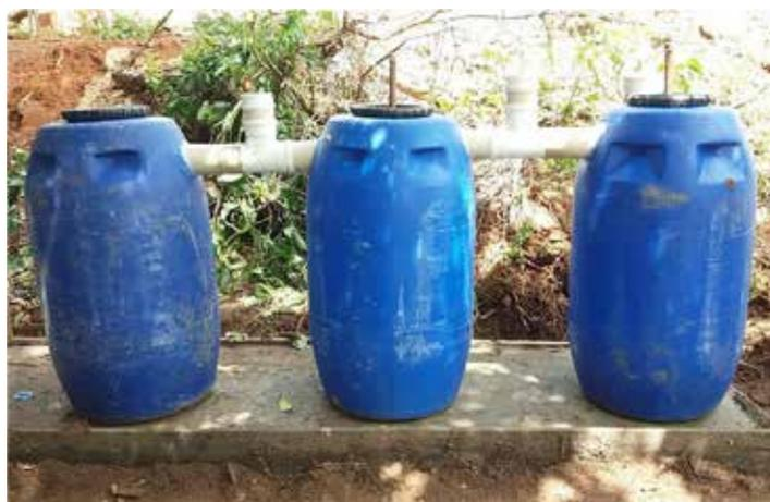
Figura 26: Fossa séptica de baixo custo. Modelo desenvolvido pela EMBRAPA São Carlos e adaptado pela Fundação Hans Neumann. (Fonte: Fundação Hans Neumann)
