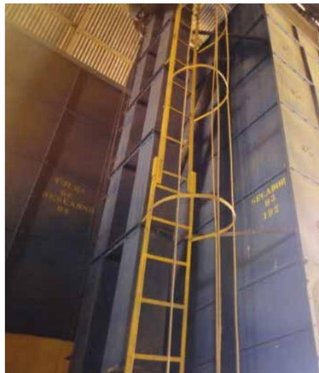
Figura 50: Escada externa com proteção guarda corpo. (Fonte: Eduardo Matavelli)
